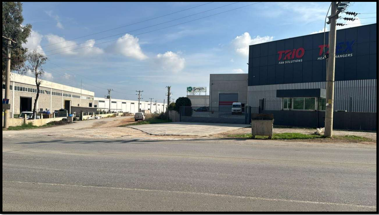
Şekil 7:Taşınmazda yer alan fabrika binası
