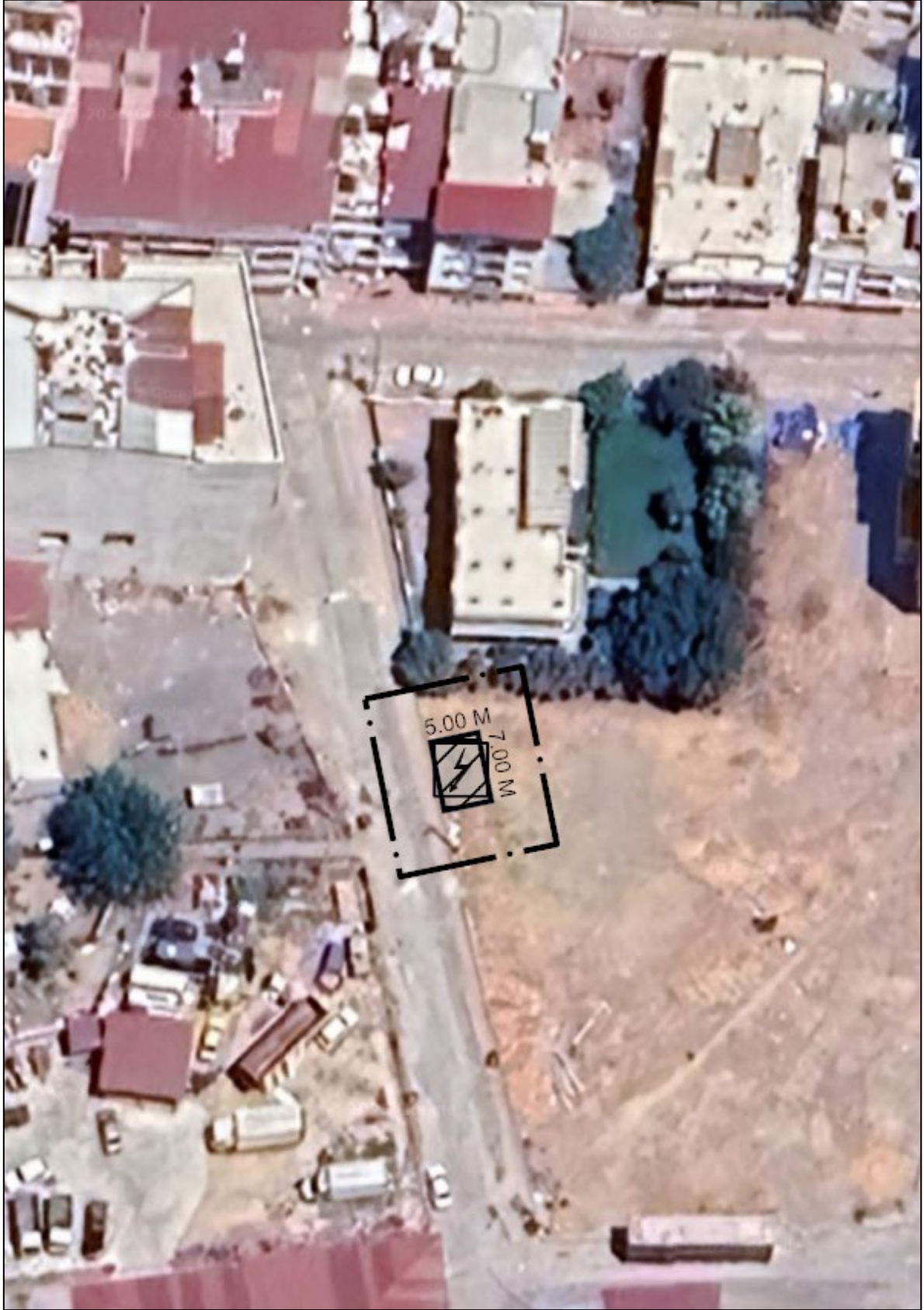
-Trafo Alanının Uydu Görüntüsündeki Konumu-
