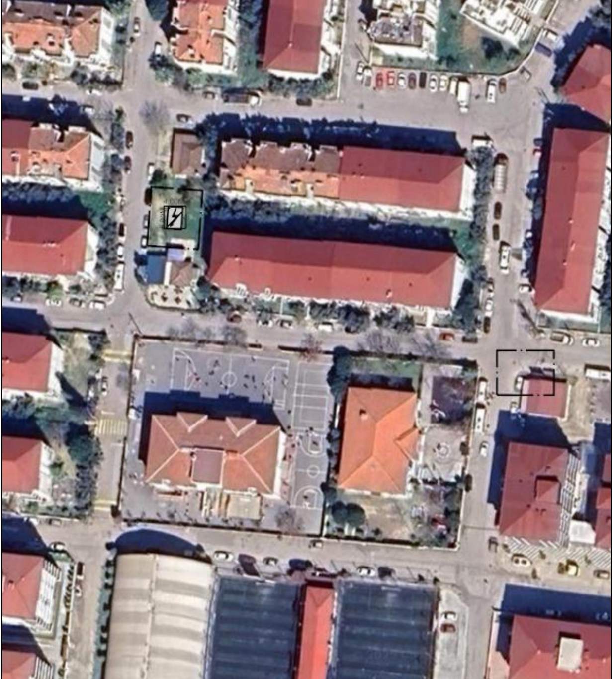
-Trafo Alanının Uydu Görüntüsündeki Konumu-
