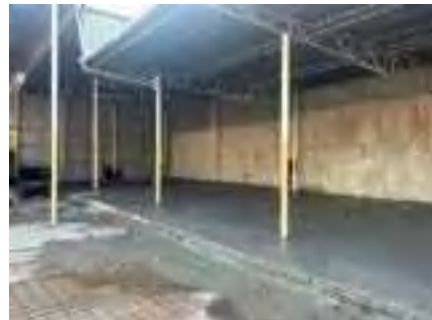
Yeni Atık Getirme Merkezi İnşa Alanı
