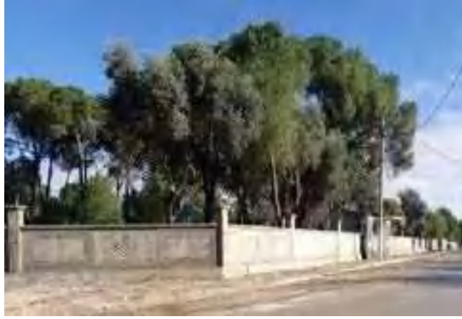
Şehitler Cami Çevre Duvarı
